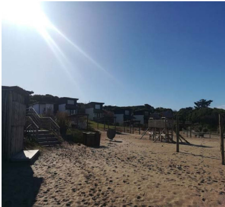
Figura 4. Construcción de cabañas por parte de la concesión UTF Playa Bonita en infracción a la Ley provincial 12.257/98 (Código de Aguas) que prohíbe el loteo y la edificación a una franja de 150 mts. aledaña al Océano Atlántico
